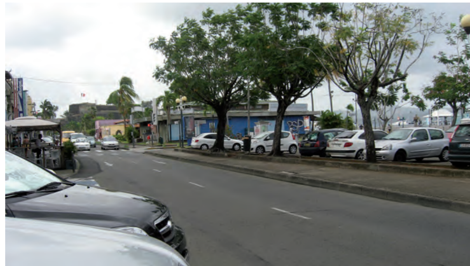
○ Rue Ernest Desproges 2014 avant travaux
